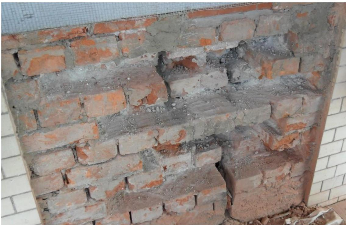
Рис. 38. Вычинка кирпича. Подготовка гнезд. Вырубка старого разрушенного кирпича
