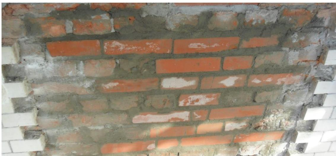
Рис. 39. Вычинка кирпича. Укладка нового кирпича
