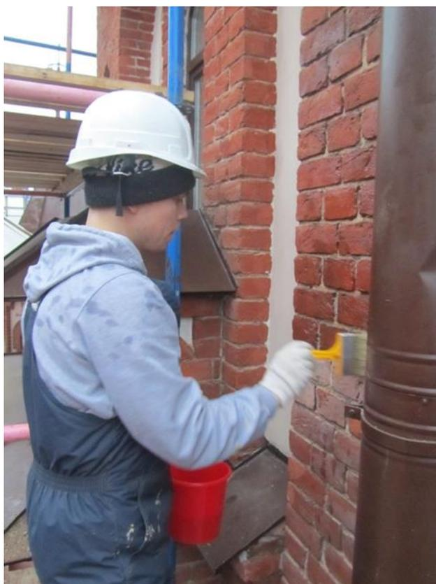
Рис. 44. Гидрофобизация кирпичной кладки при помощи кисти
