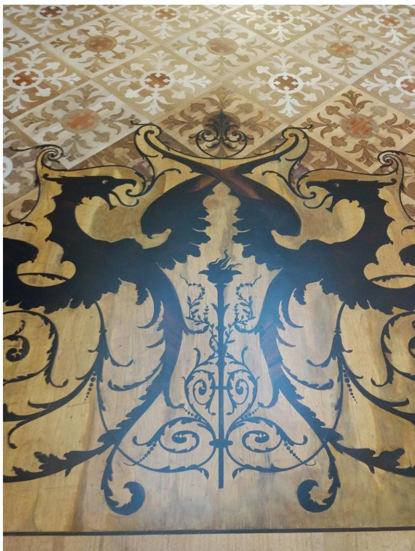
Рис. 47. Состояние наборного паркета после проведения реставрационных работ, пробная расчистка. СПб, Галерная ул., д. 33, Особняк Державина
